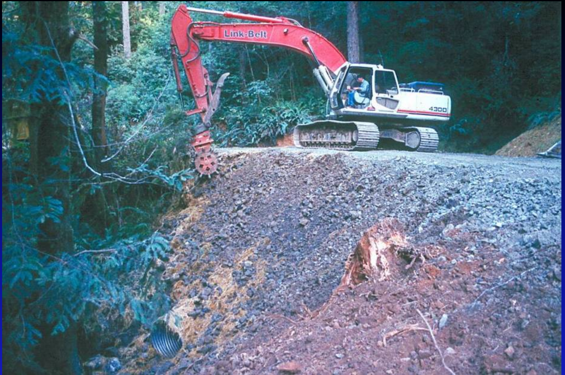
Fill compaction
